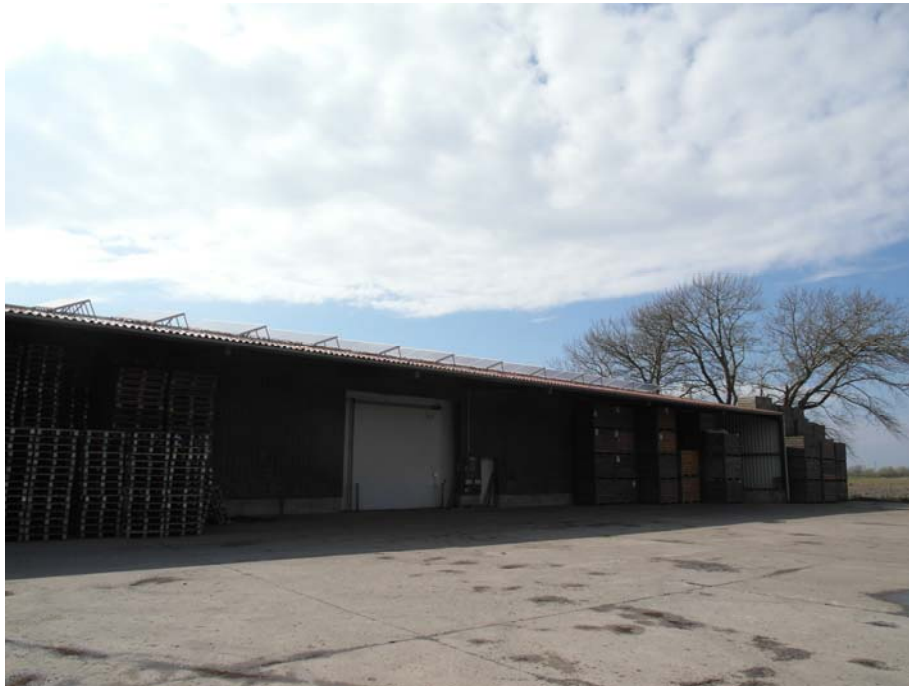
Auf dem Dach der Arbeitshalle ist eine Photovoltaikanlage installiert. Im Jahr 2010 wurden über zwei Windmühlen 2.240.000 kWh „Windstrom“ und über diverse PV-Anlagen auf den Hallendächern etwa 366.000 kWh „Solarstrom“ erzeugt. (Westhof BIO-Gruppe)
