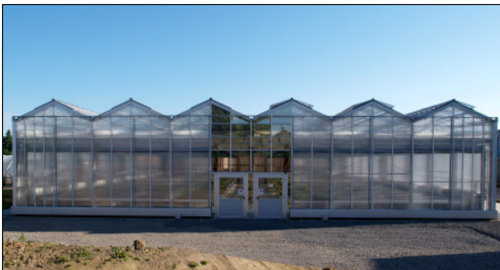
Foto 1: Niedrig-Energiegewächshaus des ZINEG-Projekts in Hannover (Süd-Ansicht).
