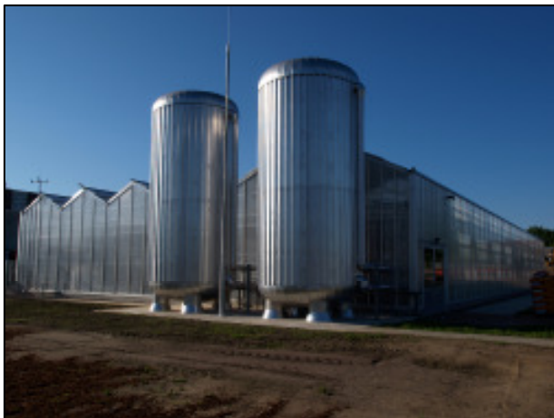
Fotos 4 und 5: Li. Pufferspeichertanks, re. Wärmekonvektor.
